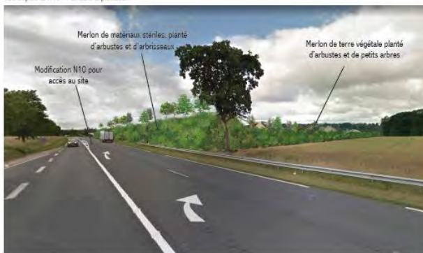
Vue depuis la N10 - Pendant exploitation
